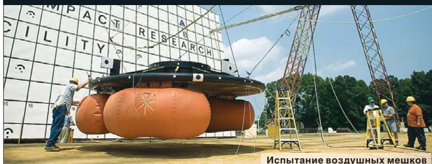
Испытание воздушных мешков
